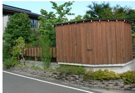
ウィンドキャッチャー窓の前を流れる風を取り込む袖壁。西の外壁が伸びたウィンドキャッチャーは、夏には西日を遮るとともに道路からの視線を遮る。
