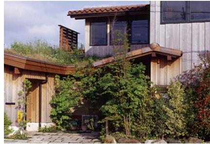
屋上緑化による照返し防止・植物の蒸散による冷却効果
