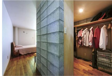
コンクリートブロックの隔壁は、OMソーラーの太陽熱を蓄熱し、夜間も寝室を快適な温度に保つ。
